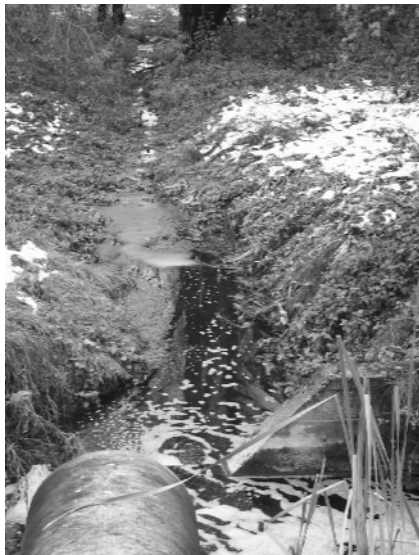
Abbildung 3 Permanenter Sickerwasserabfluß
